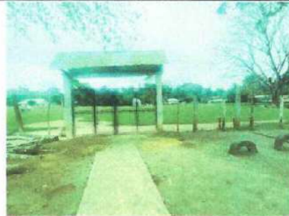
Foto 2: ESTRUCTURA DE CIRCULACIÓN EN MAL ESTADO.
